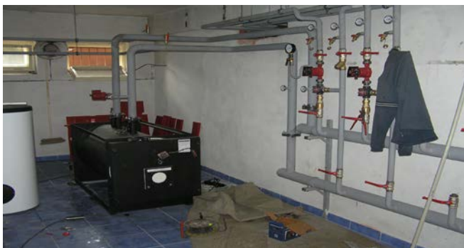
Rekonstrukce garáže na kotelnu v hlavní budově školy – kotelná přestěhována ze střechy do suterénu
