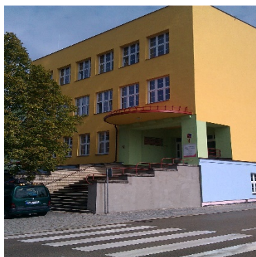
Budova školy Miřiovského 678
